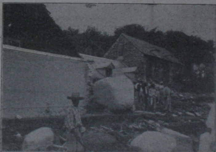
Fig. 10. — Maison démolie par le choc d'un bloc au cours d'une inondation à Basse-Pointe.
